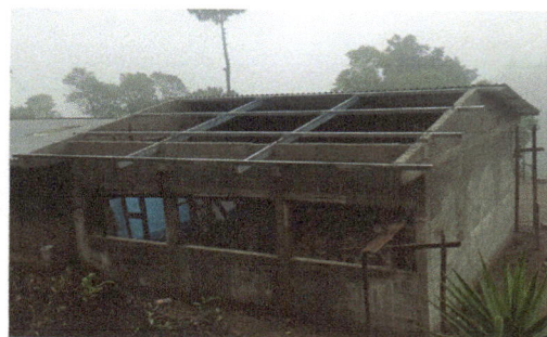
Foto 2: Vista donde se puede observar el proceso de colocación de techo.
