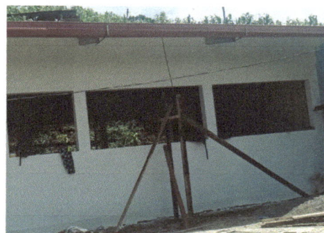
Foto 4: Imagen de ventana en proceso de tallado.
