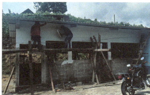
Foto 3: Fotografía que evidencia el proceso de reparación de repello y cernido de paredes.
