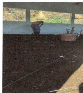
Foto 6: Preparación del entortado de cemento.
