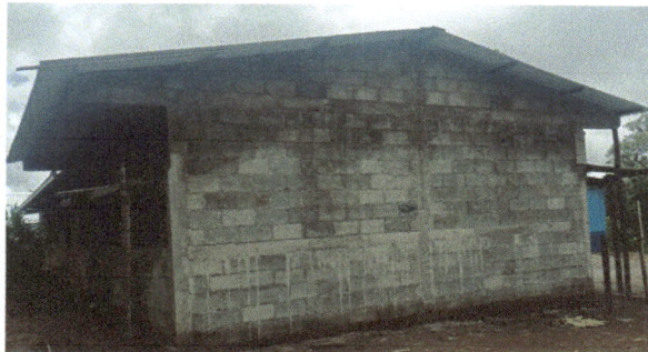
Foto1: Vista de pared en donde fue rehabilitada antes del repello..
